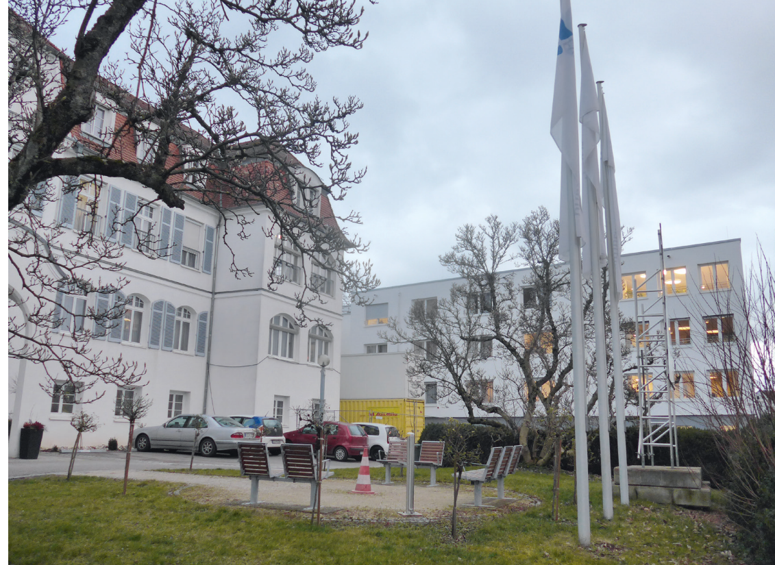
Ab Mai 2020 wird der Zentralbau, der sog. historische Gebäudekomplex (ehem. Krankenhaus), komplett saniert. Die Bewohner sind bis dahin alle in den neuen Südflügel umgezogen (Bild unten).
